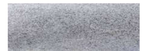
有涂层，工艺后，无明显裂纹
